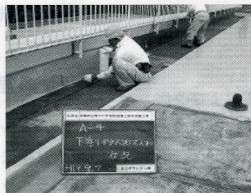
写真-5 立面部の防水施工①
