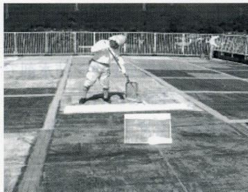
写真-1 プライマー塗布
