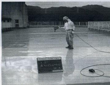
写真-7 防滑トップコート吹付け
