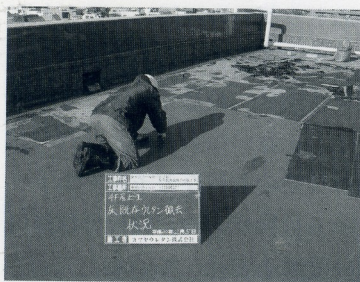
既存防水層撤去
