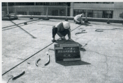
④屋上目地材撤去—既存目地材を掘り起し撤去
