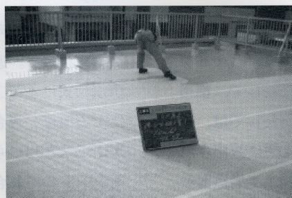
⑧ウレタン防水—HCエコブルーF NEV 下塗り
