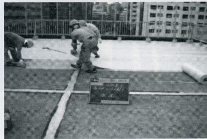
⑥X-1 緩衝シート貼り—MFテクノシートPを貼り付け
