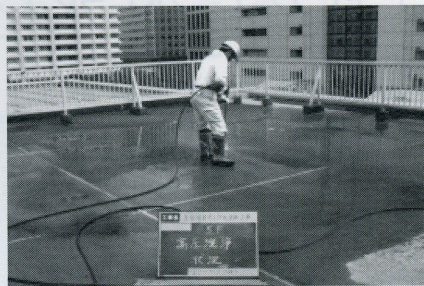
③高圧水洗浄—保護モル表面の汚れ除去
