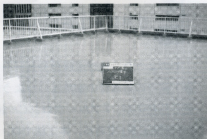
⑫トップコート塗布—HCトップWA2 回目塗装で仕上
