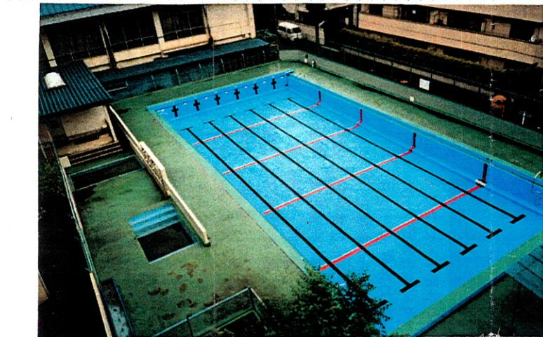
ヨツヤウレタンは五月、表題プールの工事を受注し六月二十日の工期に間に合せて完成しました。当工事は塩ビシートの機械固定工法で四百二十坪のプー
