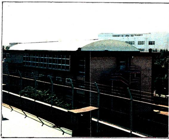
七月末ヨツヤウレタンは朝霞市から表題工事を受注し、九月初旬に完成した。当工事は瓦棒葺き屋内運動場屋根をリニューアルする工事で、在来屋根が経年で雨漏りを生じたために行う改修工事です。金属のハゼ部を非加硫ゴムシートテープで被覆補強した後に、屋根全面を超速硬化型ウレタン吹付で防水層を形成させる工事であった。
