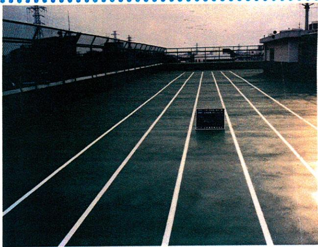
昨年十一月地元の老舗広拓建設から、表題工事を受注し。二月下旬に完工した。当工事は、屋上の在来フエンスのネット取替え、既存ウレタン面にオーバーレー防水を行う仕事に先立つて、パラペット関係の浮き部注入処理や、床の伸縮目地の脱気処理、床の不陸整正を行った後に、全体をサンダー研磨で旧塗膜の劣化表
