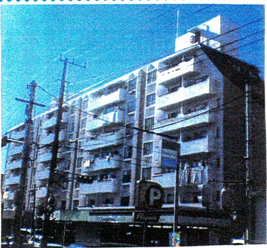
ヨツヤウレタンはオガタクリエートの担当した表題工事で、防水工事、外壁浮き部エポキシ注入、外壁塗装に微弹性ウレタン塗り、廊下に塩ビ防滑シート貼り、各所金属部塗装、サッシュ廻りシーリング打替え等、の施工を担当しました。工事は配管取替えや、エレベーター機械取替えを含む五ヶ月に及ぶ工事であつた。作業足場の組み立てから。撤去その後の防水
