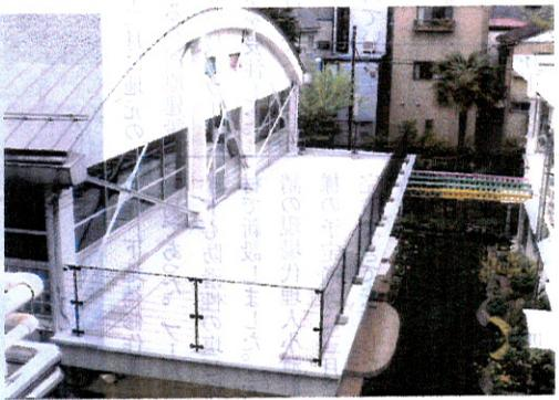
新宿区の老舗木曾建設が受注した表題工事の中で、屋根部防水工事をヨツヤウレタンが受注し、三月末工期で完工しました。在來の屋上緑化材を撤去し新たにアスファルト防水で復旧を行つたのは、元請担当者亀田様の言葉でした。
