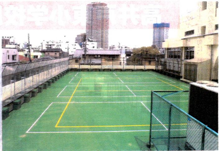
二月末にアスカラ施設が受注した表題学校工事に、ヨツヤウレタンのロバストコート材が採用され、屋上運動場にロバスターN-150による弾性床防水が施工された。一般部は通気緩衝工法のロバストコートF-I
