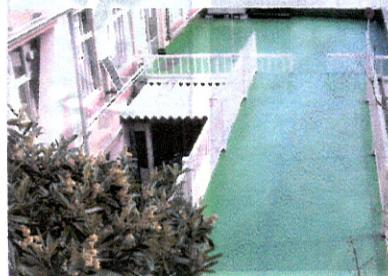
根防水であったり、西戸山二中では音楽室屋根が塗装で劣化が激しい為、全面を撤去した後当ブールは在来のブールコートのエポキシ系樹脂で改修したものです。工事に先立ち飛び込み台は危険防止のために撤去した。近年は全ての学校でも同じように撤去する方が必
