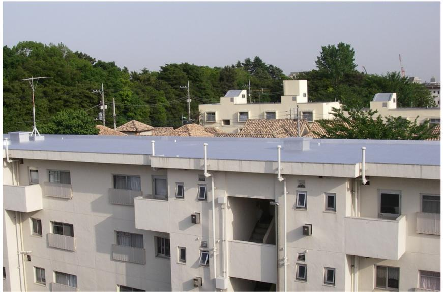
ヨツヤウレタンは、二月中旬に独立行政法人国立印刷局の発注工事を落札し、五月末に完工した。当工事は船堀宿舎、川崎宿舎、用賀宿舎、小豆沢宿舎、淀橋宿舎、上高田宿舎、江古田第一宿舎、高円寺南第二宿舎等の八箇所に分散する工事であった。従来がゴムシート防水でシルバークラウドの露出防水であったが、長期の経年で漏水を生じたために、今回の補修工事が必要になったものです。工
