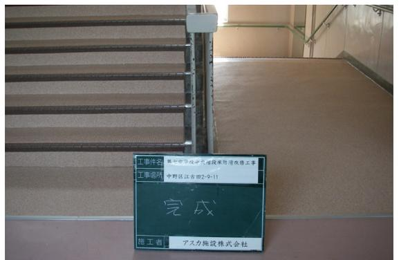
ヨツヤウレタンは三月中旬に、中野区から表題学校の中央階段部床修繕を受注した。床を樹脂モルタルで下地調整した後、タキロンの階段踏み面防滑性シート貼り七〇段や、階段蹴上げ面防滑性シート貼り七十段、更には階段踊り場面防滑性シート貼り五十㎡を行った工事でした。学校行事に支障の無いように完成でき安堵した工事でした。当社の施工担当は熊田実技能士でした。四家記
