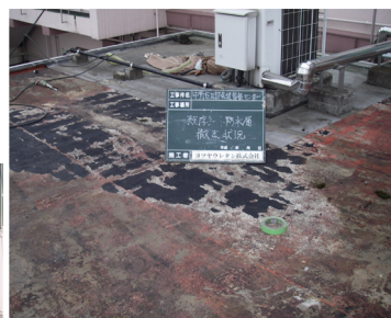
撤去状況(上)と防水工事完成写真(左)
