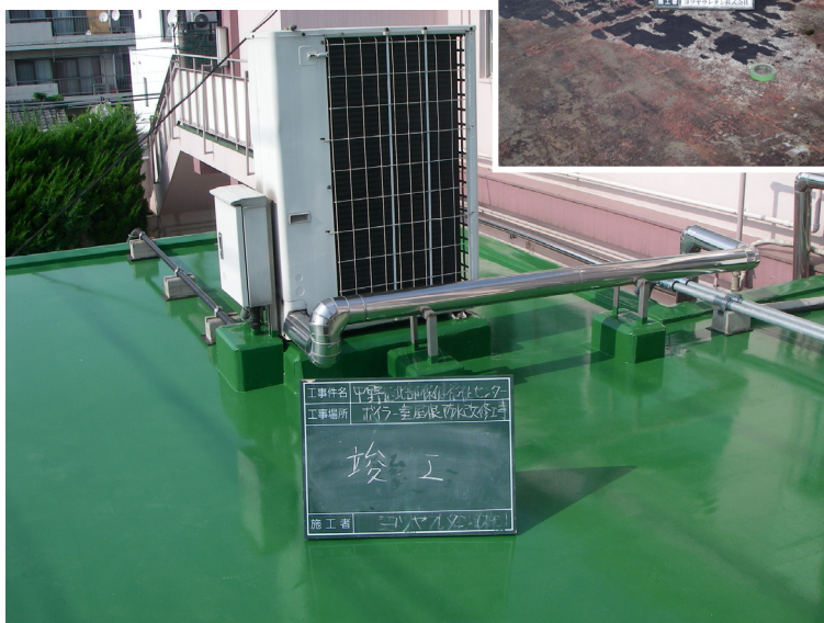
撤去状況(上)と防水工事完成写真(左)
