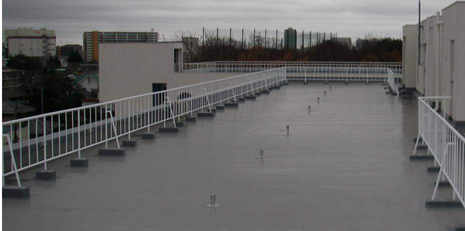
東京国税庁発注入札工案件でしたが、ヨツヤウレタンは幸運にも受注できた工事でした。十月八日からの着工で一月二十日完工予定の作業であったが、十二月二十二日には完成できた工事であった。予定した遮熱塩ビシート厚一、五ミリ材の手当てもスムーズに出来たので、機械的固定工法の防水作業も効率的に進行出来ました。立面の一部にはウレタン防水X-II施工を行う作業も伴った工事であった。当社現場代理人は熊田実が担当しました。
