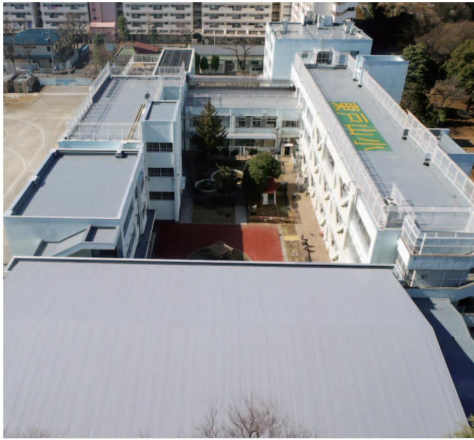
ヨツヤウレタンは、去年7月に受注し、一月中旬に完工しました。校舎屋上をX-1で1,820㎡改修、下地は、水性エポキシ樹脂モルタルで整正
