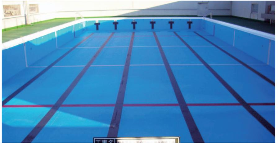
十月中旬に、杉並区の老舗ハタ建設工業株式会社が受注した表題工事を、ヨツヤウレタンはプールサイドをウレタン防水で、プール内部は塩ビシートのサンロイドDNで施工し、十二月中旬に完工し引渡されました。
