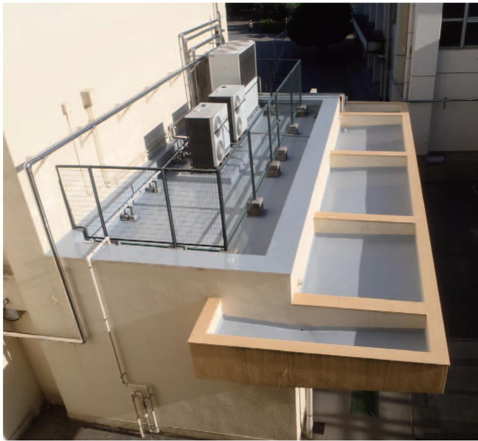
5月に着工し8月3日完成の表題学校は、既存が熱アス保護モルタル仕上げで長年使用されてきて、今回劣化の為改修するに及んだものです。在来モルタル表面を高圧水洗浄した後、樹脂モルタル2mmで平坦に補修した後に、床部ウレタン防水X-I、立面部X-II仕様で完工した。施工は小林が担当しました。
