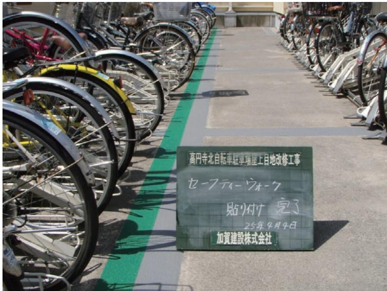
3月初め加賀建設(株)より表題工事を受注し3月末に完成しました。建物駐輪場の伸縮目地が劣化したので改修となり、M=25の目地材を研り撤去し、新たにウレタンシーリングで総延長29.4mを打替えした後、耐衝撃性、耐摩耗性のあるHCパークCPI25NRI工法で仕上げた工事でした。当社は小林現場代理人が担当しました。
