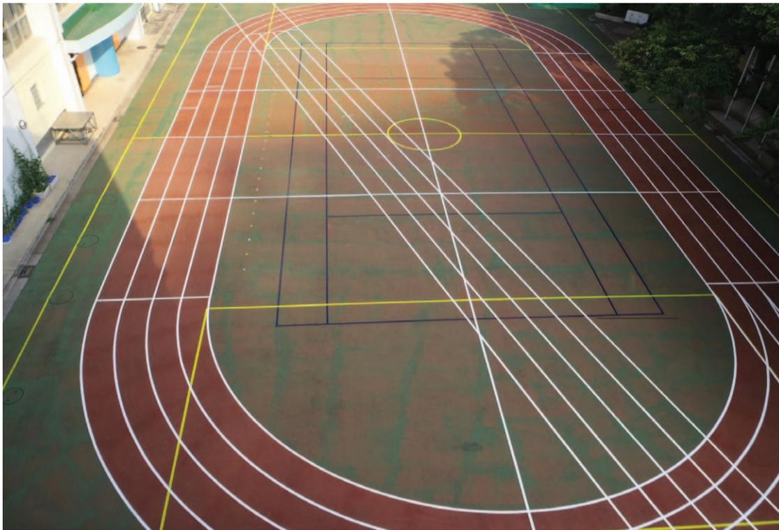
8月に表題の校庭ライン引きを実施しました。現状が透水型ゴムチップ舗装で長期間にわたり使用されていた校庭は、経年劣化によりライン塗装が消滅していました。緊急
