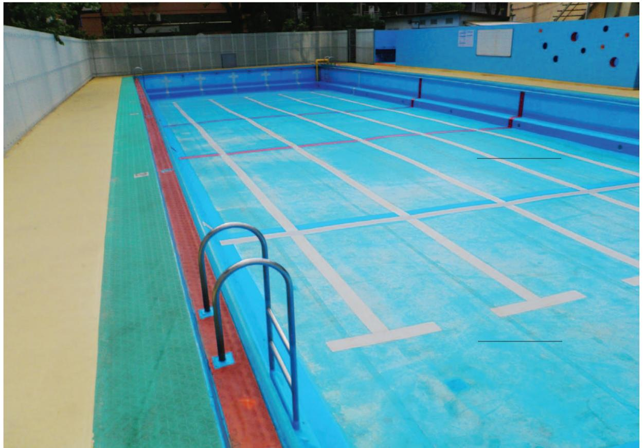
プール開き前にプールDNシートの補修を行った。長年の使用で小さな傷が多数あり、探傷検査機を用いて受けた。増し貼り補修を行った。四家記
