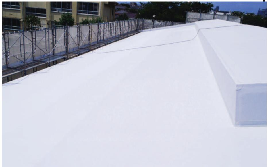
綜和建設株より表題工事の屋根の防水工事を受注し、8月上旬に完了した。約700㎡の体育館の折半屋根に高反射型の防水シートを施工したもので、防水下地を平らにする為に50mmの硬質ウレタンフォーム断熱材を2枚貼り、その上に太陽熱高反射型の防水なので、防水性に加え断熱・遮熱性も得られる防水工法です。担当は小林正秋でした。四家記
