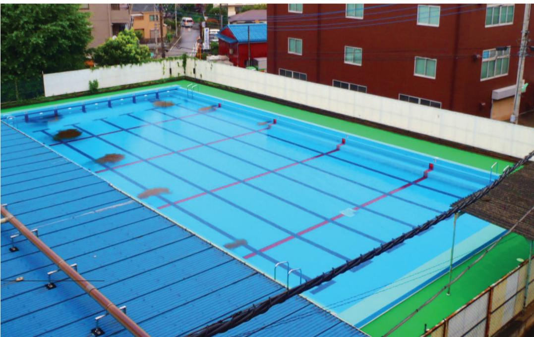
当プールは経年で劣化した為、改修するに至った。今回の仕様は塩ビシート機械固定式工法のサンロイドDNシート防水工法で実施しました。4月下旬に開始、6月20日に完成した。床
