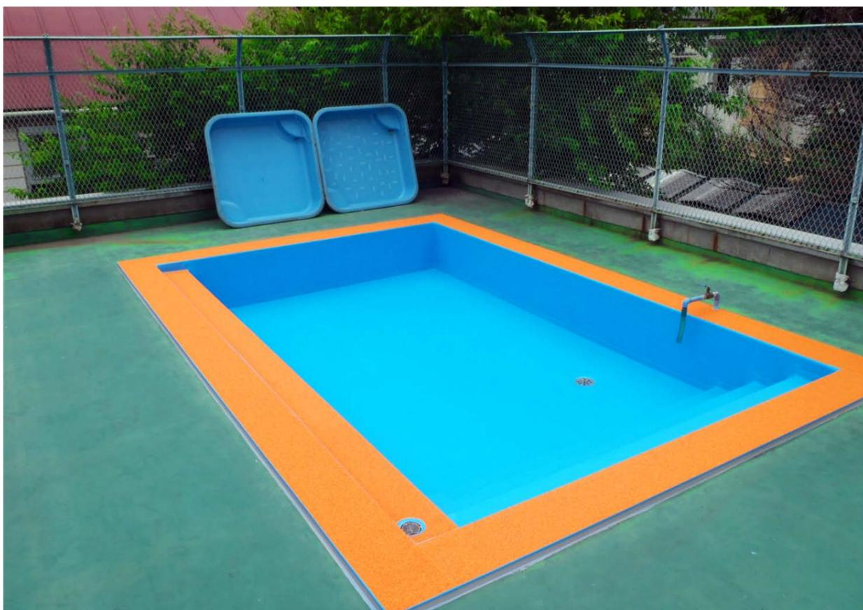
6月中旬に三鷹市営繕課からの要請で現調し、鋼板処理作業の後に排水口取付を実施し、塩ビシート系のサンロイドDN
