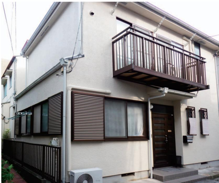
経年で傷んだ、屋根や外壁の塗替えを行いました。屋根は水性シリコントップ仕上げを行い、壁面には微弾性フィラーに水性セラミックシリコントップで仕上げました。新井武夫が現場監理し完工しました。(四家記)
