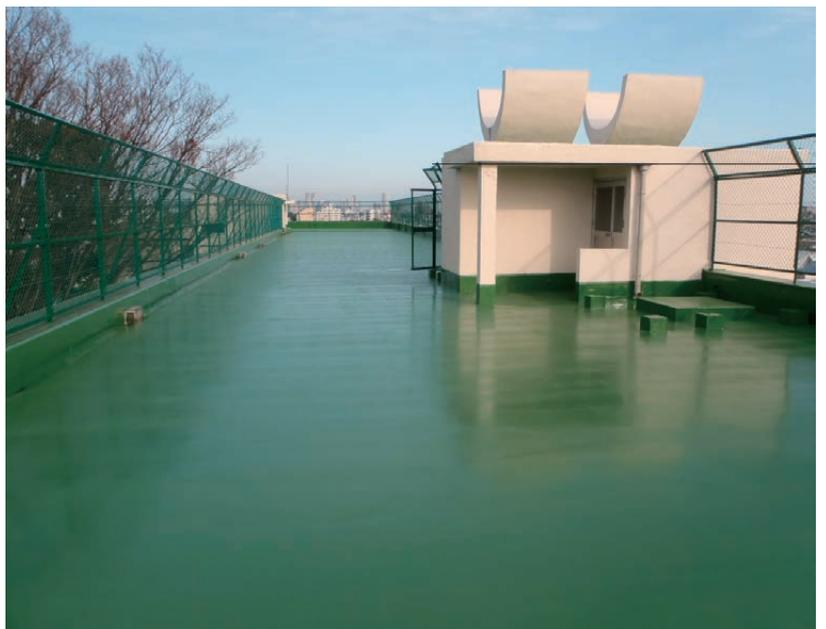
十二月に杉並区の一(株)大島建設様から、表題工場の屋上防水改修工事を受注し三月に完工した。校舎屋上の旧防水面をサンダー目荒し処理後に洗浄し、歩行用ロバストコートSG工法にて床面1,769㎡と立面を651㎡をそれぞれ行いました。現場担当は四家昭雄でした。(四家記)
