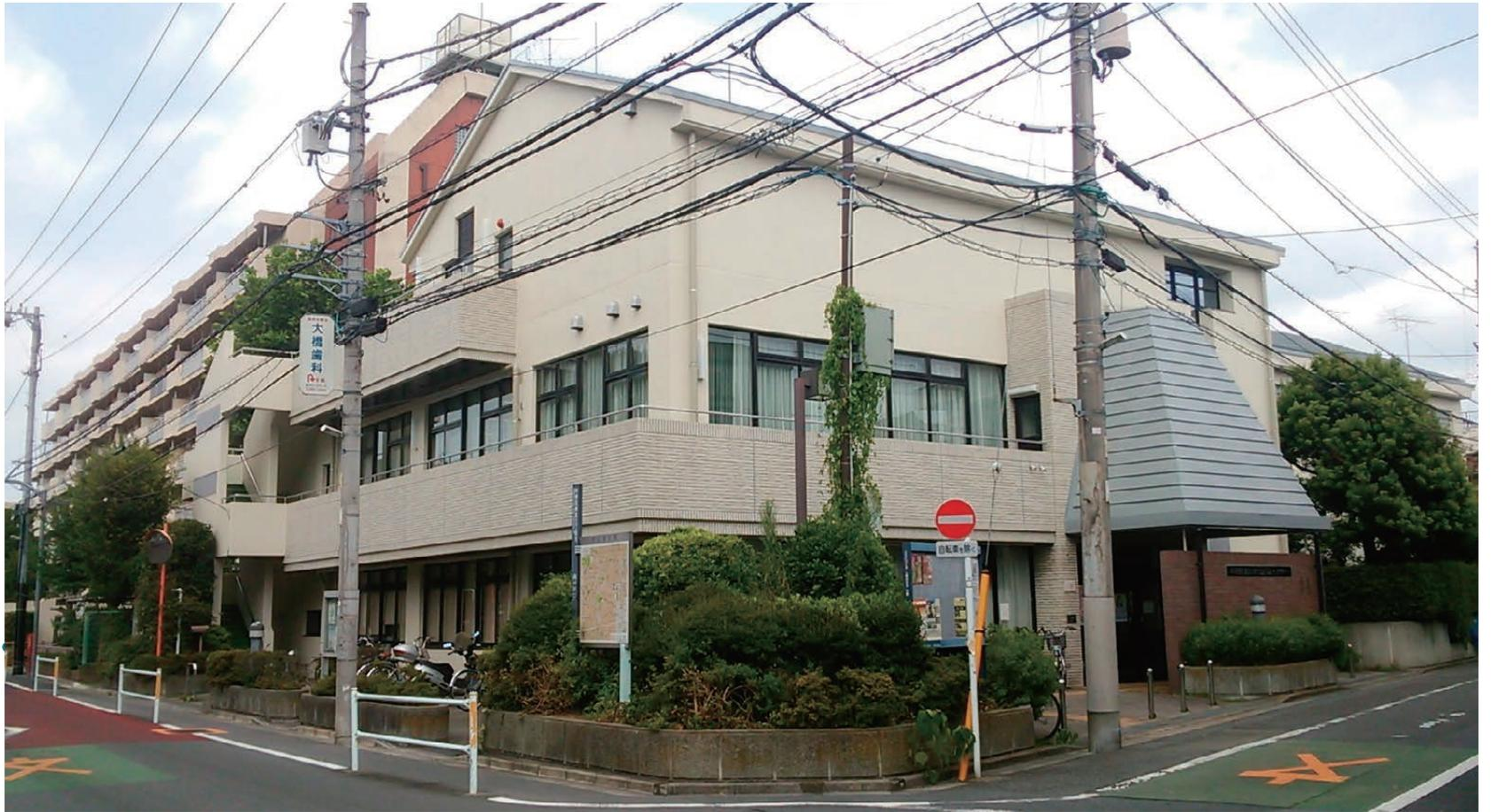
十一月に中野区の(株)大日建設様から、表題工事を受注しました。屋上部分のウレタン塗膜防水改修工事に加えて銅板屋根へのウレタンスプレー防水工事、外壁の防水塗装工事、外壁タイルの剥落防止工事と建物の総合防水工事でした。三月までの工期の中、元請の岡本監督員と徹底した打ち合わせ・工程管理の下、無事に引き渡す事が出来ました。現場担当は、四家でした。
