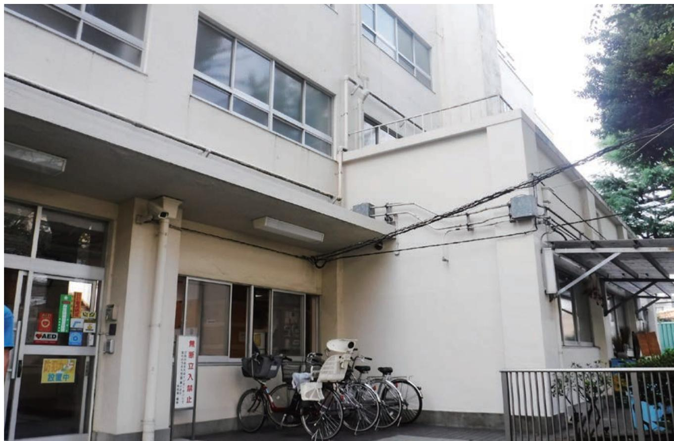
11月中旬に新宿区から表題の外壁補修工事を受注し、11月下旬に完工いたしました。経年劣化した外壁塗膜を完全除去し、下地をカチオン材にて調整した後に複層塗材シリコントップコート仕上げにて補修いたしました。施工担当は、石井が担当いたしました。(都記)
