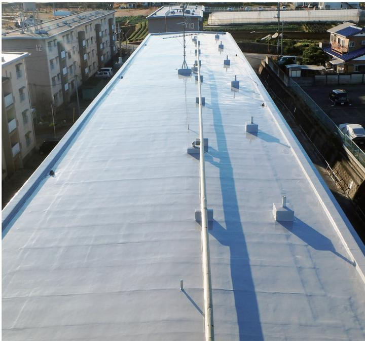
表題の工事をヨツヤウレタン株式会社多摩支店が平成28年10月上旬に受注し、12月下旬に竣工しました。今回で3棟目となる防水改修でした。屋上700㎡を保土谷バンデックス建材株式会社の機械固定ウレタン複合工法で完工しました。工事担当は小林賢二でした。(猪野 記)
