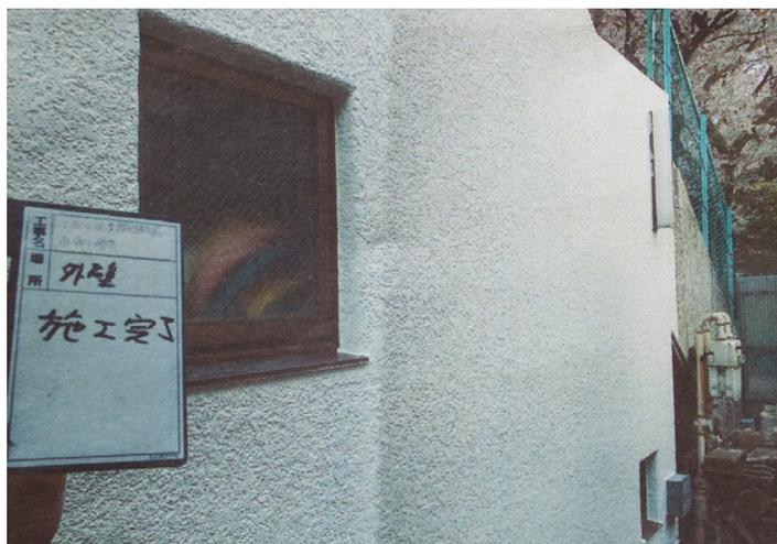
表題の工事は、当社が中野区から平成29年4月に受注、平成29年5月に完成しました。施工はまず室内側からコニシ株式会社低圧注入工法にて、亀裂処理を行い外部はフジワラ化学株式会社のHR工法にて施工しました。雨漏りが止まり児童館の皆様にご迷惑がなくなりました。感謝されました。工事は熊田が担当しました。(記 熊田)
